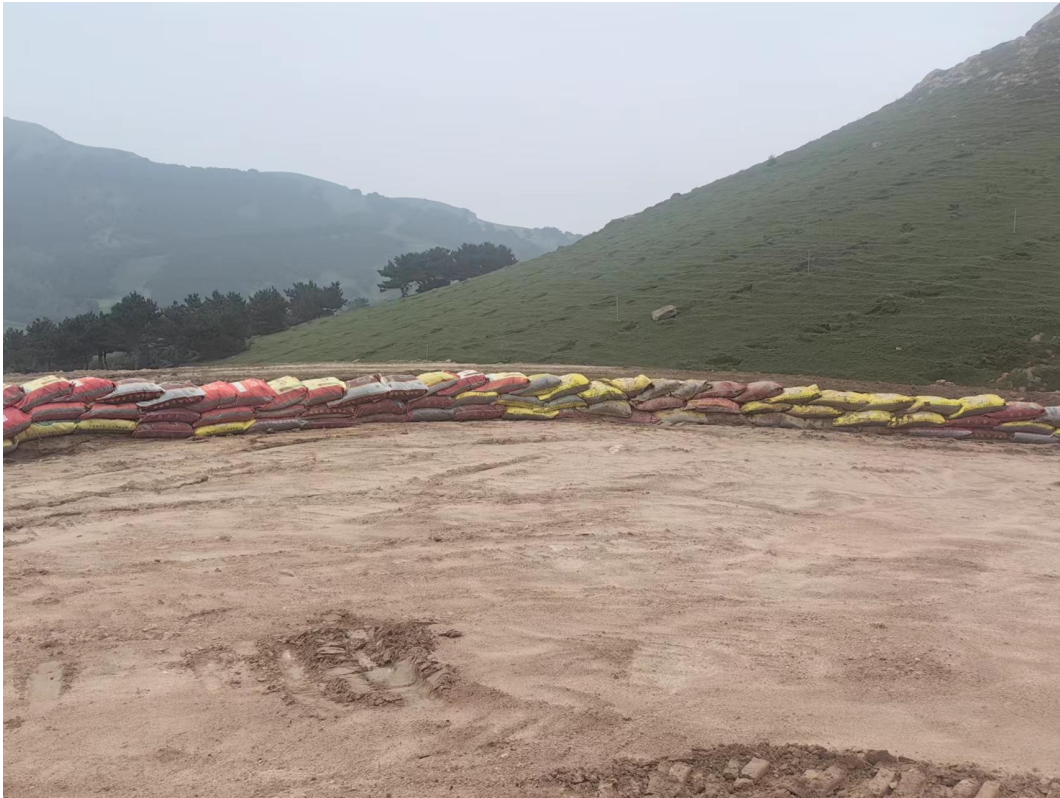
图0-3编织袋挡土墙的效果
